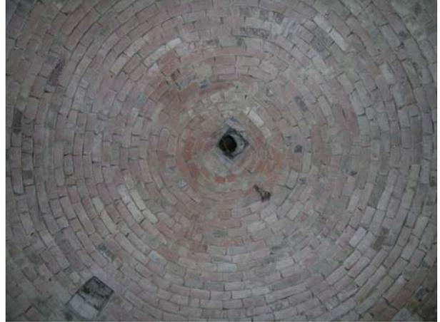
**B. Volta forata per il meccanismo idraulico**
